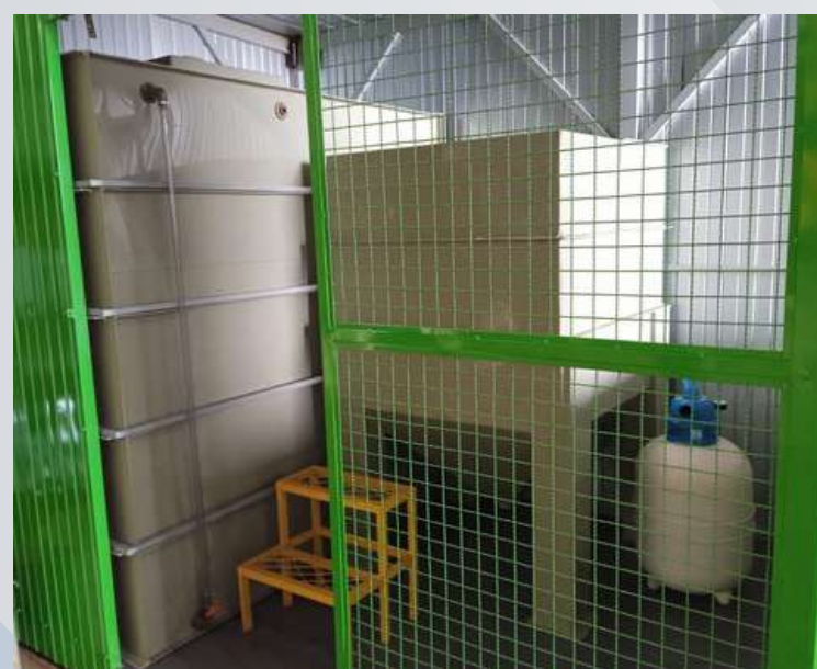
Escada de acesso
